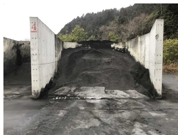
真庭バイオマス発電所
