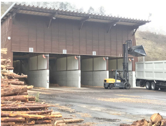
真庭バイオマス集積地第一工場
